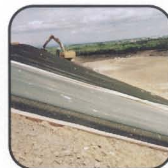
Beziers, Франция Дренаж и противозерозивная защита полигона ТБО
