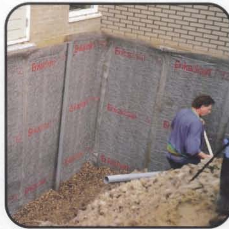
Velp, Нидерланды Стена подвала
