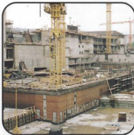
Stuttgart, Германия Потерянная опалубка
