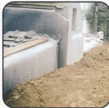
Tubingen, Германия Стена подвала
