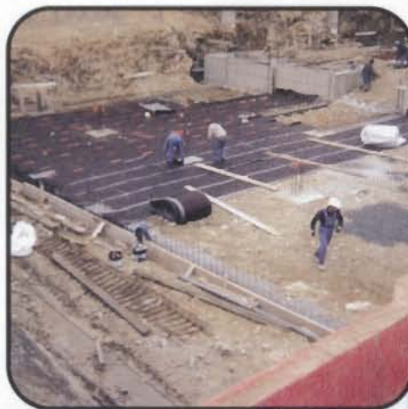
Vannes, Франция Подземная автостоянка
