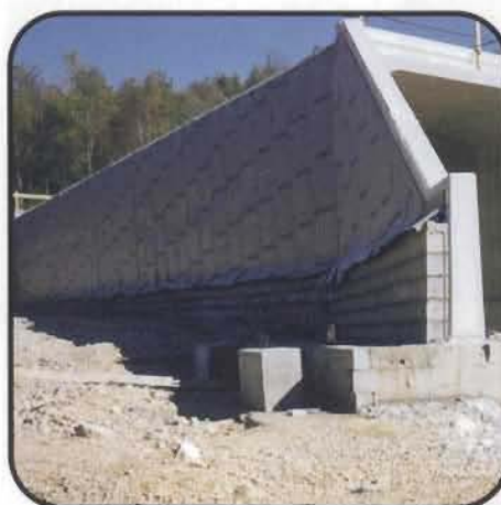
Франция Дренаж туннеля, строящегося открытым способом
